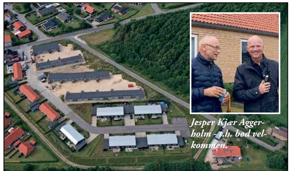
De nye boliger »Ved Jernbanen«.
