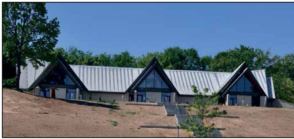
Dronninglund Kunstcenter præsenterer sig på en hel anden måde end før, efter at det imponerende trappeanlæg nu fører fra parkeringspladsen og op til selve bygningen.
