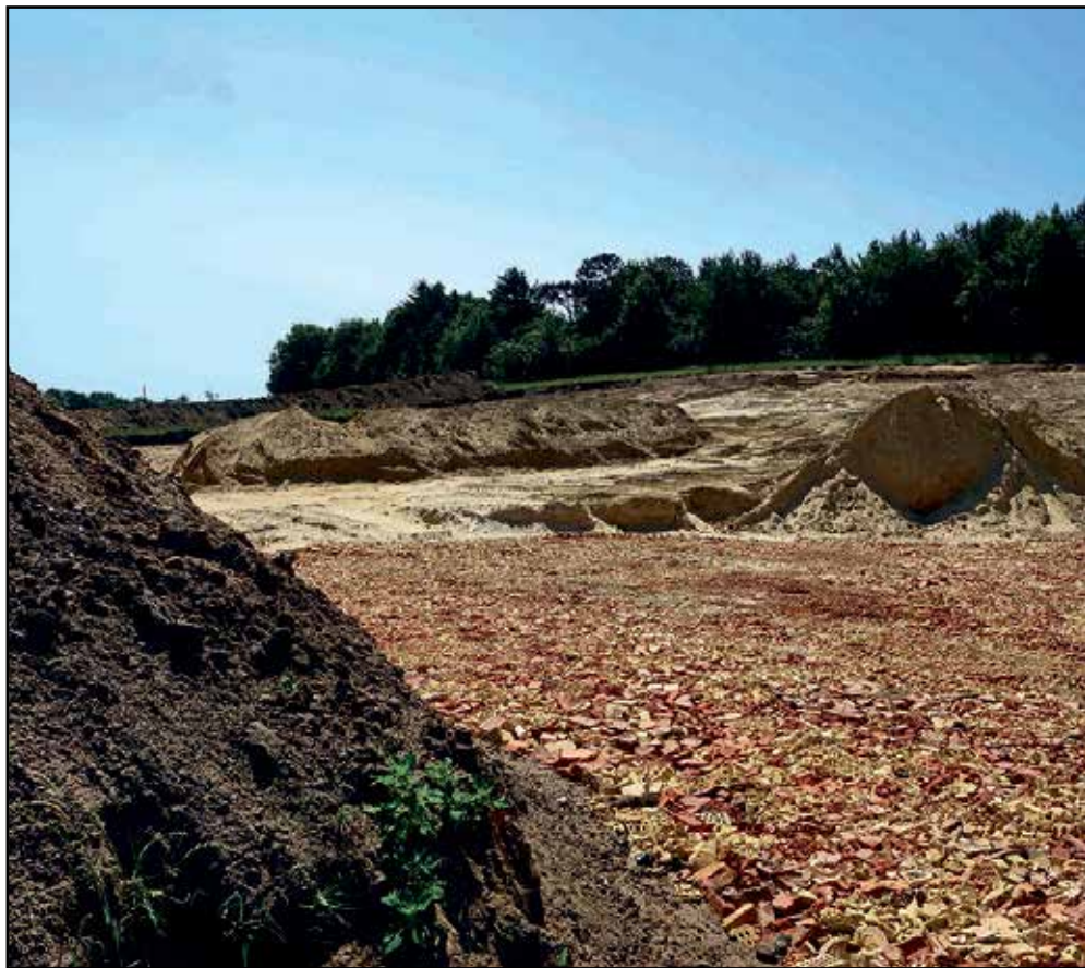
Råstofindvinding på Houvej er godt i gang.
