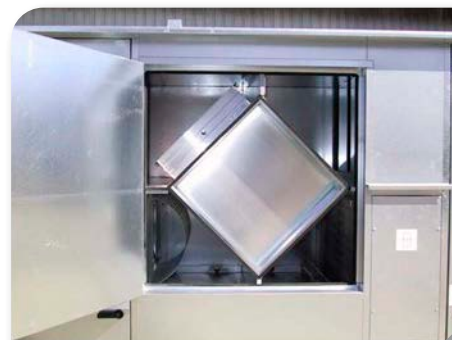
Lüftungsanlage mit Kreuzwärmetauscher zur Wärmerückgewinnung.
