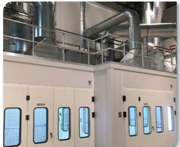
Oben: Kongsberg Defence & Aerospace, Norwegen. 3 Lackierkabinen mit horizontaler Belüftung.
