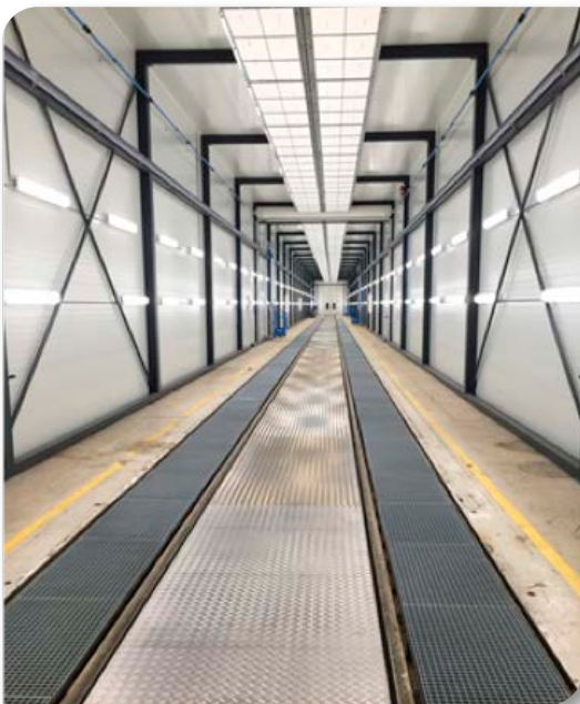
Zum Beispiel: 120 m lange Lackierkabine mit mehreren trennenden Rolltoren. Die geöffneten Rolltore sind nicht sichtbar.
