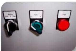
Branchez le câble d'alimentation qui l'accompagne. Le panneau de commande doit être monté sur le mur à une distance minimale de 1 m de la boîte.
