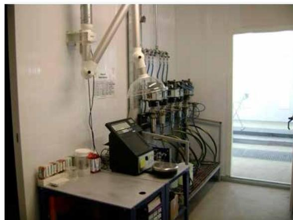
El modelo que aparece en el dibujo para la incorporación de aire de sustitución tiene como condición previa que la sala de mezcla pueda categorizarse como una ubicación de trabajo no permanente, lo que corresponde a prácticas habituales según el Organismo para la seguridad y la salud en el trabajo. Para ubicaciones de trabajo permanentes, el aire de sustitución debe inyectarse desde fuera, una solución más amplia y costosa.
