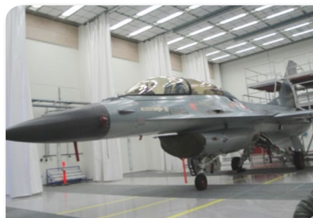
Flymaledok med zone-opdelt vertikal ventilation.
