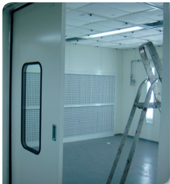
Ovenfor: Halden Fængsel, Norge. Udsugning i bagvæg, indblæsning i loftet.
