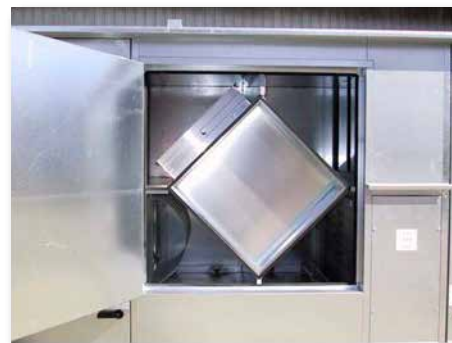
Mindre aggregat med enkel korsvärmewäxlare.
