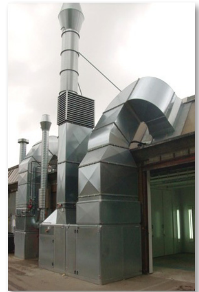
Einheit mit Wasserheizfläche.
