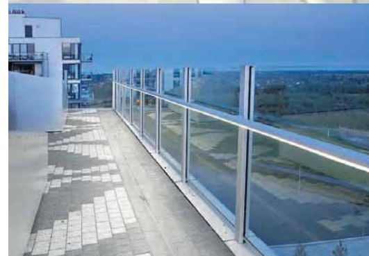
LED-håndlisten er diskret, men effektiv og er monteret udvendigt på alle trapper og ved alle gelændere.
